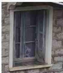
fenêtre bois & volets à lames à l'américaine rabattables en tableau
