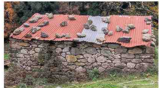
Exemples de matériaux de couverture observés à Ghisoni et Sampolo : tuiles canal, tuiles romanes & tuiles plates (L a marseillaise) pour le bâti, les constructions agricoles sont couvertes par une tôle ondulée métallique
