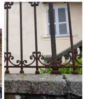
Détail de la ferronnerie du mur de clôture
