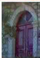
portes bois à 2 vantaux : rectangulaire et cintrée & imposte verre
