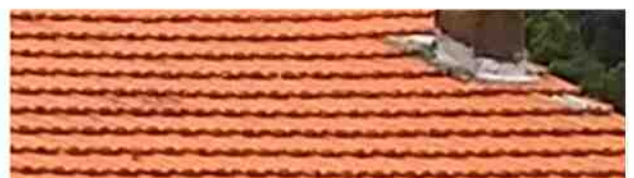
Tuiles mécaniques (de type marseillaises, très répandues dans le village)
