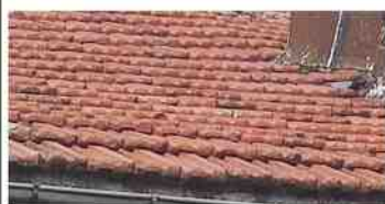
Tuiles plates mécaniques dites la Marseillaise
