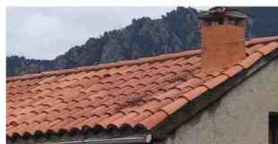
Rive composée d'un simple débord en tuiles canal & rampant maçonné couvert par des tuiles canal
