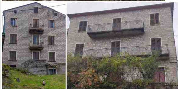
Photographies de constructions à Ghisoni
