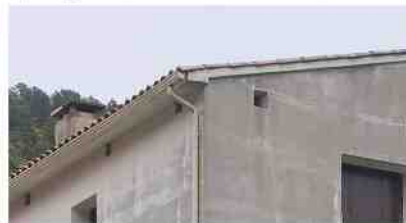
Corniche plate et rampant en béton couronnés de tuiles canal
