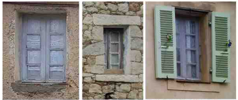
Fenêtres bois traditionnelles avec volets pleins intérieurs
