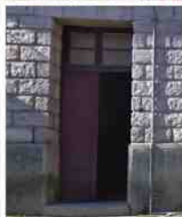
portes bois à 2 vantaux : rectangulaire et cintrée & imposte verre
