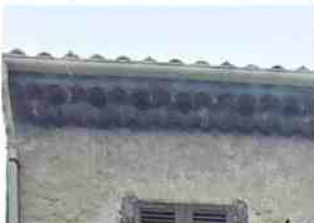
Génoises composées de 2 et 3 rangs qui soutiennent des toitures à 2 pans
