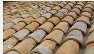
Exemple de toiture en tuiles canal
