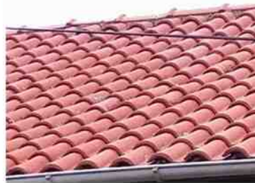
Exemples de matériaux de couverture observés à Ghisoni et Sampolo : tuiles canal, tuiles romanes & tuiles plates (L a marseillaise) pour le bâti, les constructions agricoles sont couvertes par une tôle ondulée métallique
