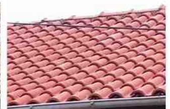
Tuiles mécaniques (de type romanes)
