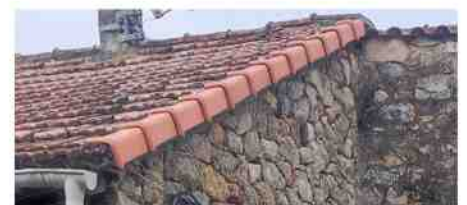
Rive composée d'un simple débord en tuiles plates & rampant couvert par des tuiles plates
