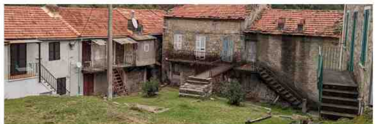
Accès aux étages par escaliers et passerelles
