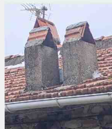
Exemple d'une souche de cheminée maçonnée, couverte par des tuiles en terre cuite
