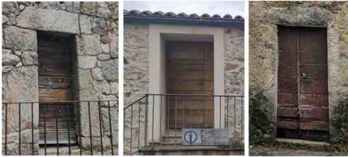
Portes à lames horizontales, à 1 ou 2 vantaux
