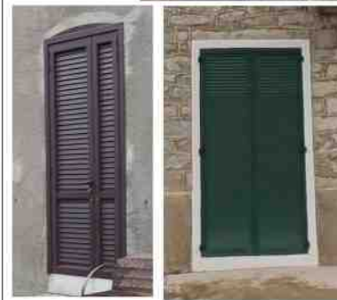
Remplacement des portes de caves par des menuiseries en aluminium à lames à l'américaine. Certaines menuiseries sont posées sur cadre.
