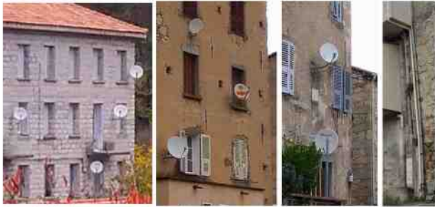
Exemples d'équipements techniques sur façades.
