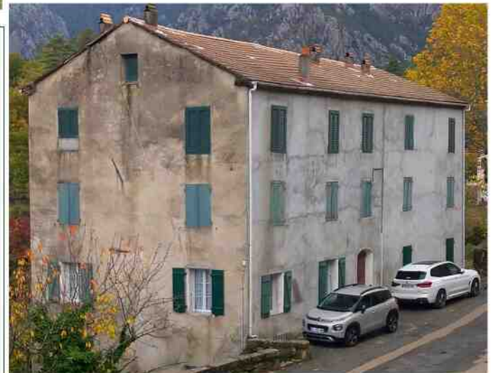
Photographies de constructions à Ghisoni
