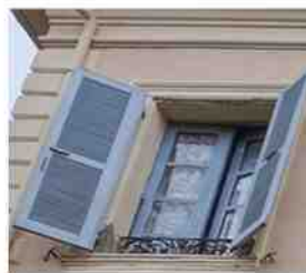
Fenêtre, porte-fenêtre et petite fenêtre traditionnelles en bois peintes composées de petits carreaux
