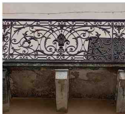
Détail de ferronnerie du garde-corps du balcon
