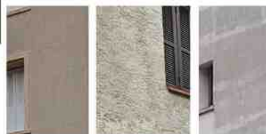
murs enduits par un revêtement ciment sur les façades de ces projets.
