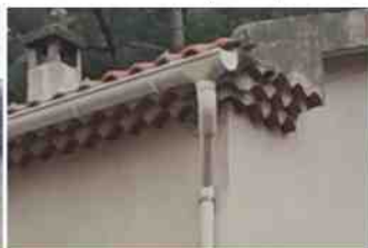
Génoises composées de 2 et 3 rangs qui soutiennent des toitures à 2 pans
