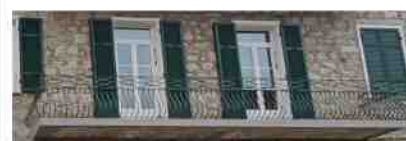
Garde-corps des balcons des casoni
