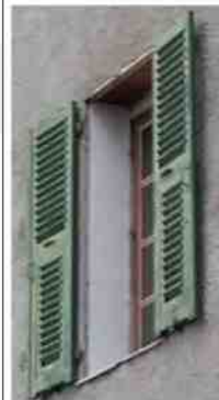
Fenêtre traditionnelle à petits carreaux et volets persiennés à la génoise. Remplacement des menuiseries par des modèles et matériaux non traditionnels
