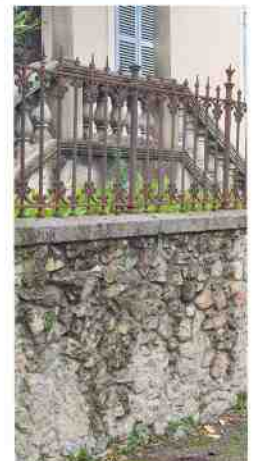
Clôture: mur en pierre surmonté d'une ferronnerie
