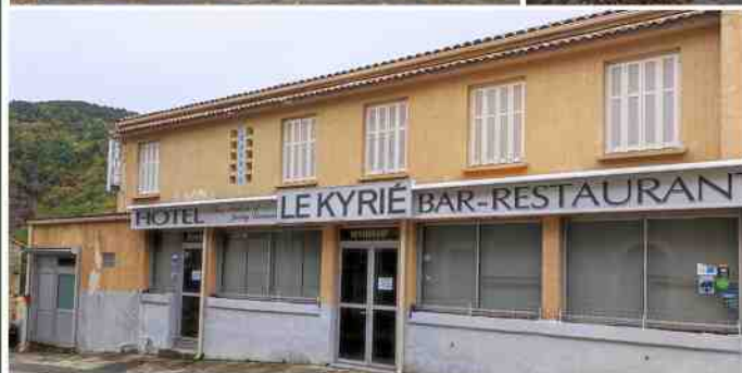
Photographies de constructions à Ghisoni
