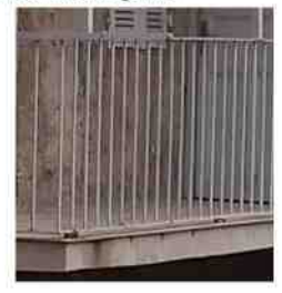
Ferronnerie à barreaudage vertical traditionnelle
