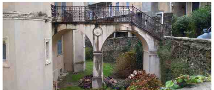
Passerelle d'accès à l'entrée arrière
