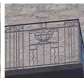
Différents garde-corps de ces constructions
