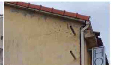
Corniche plate et rampant en béton couronnés de tuiles canal
