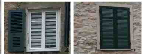
Fenêtre traditionnelle à petits carreaux et volets persiennés à la génoise. Remplacement des menuiseries par des modèles et matériaux non traditionnels
