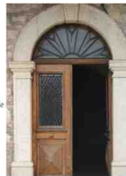
Photos d'impostes vitrées protégées par une grille de défense. Les modèles présentent des formes souples et des volutes.
